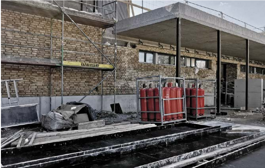
Die Sanierungsmaßnahmen an Hallenbad und Geestturnhalle liegen im Zeitplan. Noch in diesem Jahr sollen dort die sportlichen Aktivitäten wieder aufgenommen werden können. Foto: Gaby Wiefel-Keysberg
