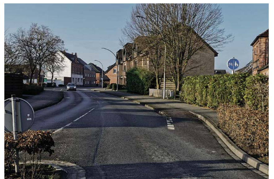
Der fahrradfreundliche Ausbau der Funnenkampstraße beinhaltet eine neue Fahrbahndecke, die Erneuerung der Gehwege, Maßnahmen zur Verkehrsberuhigung und Maßnahmen zu einer besseren Entwässerung. Foto: Wiefel-Keysberg
