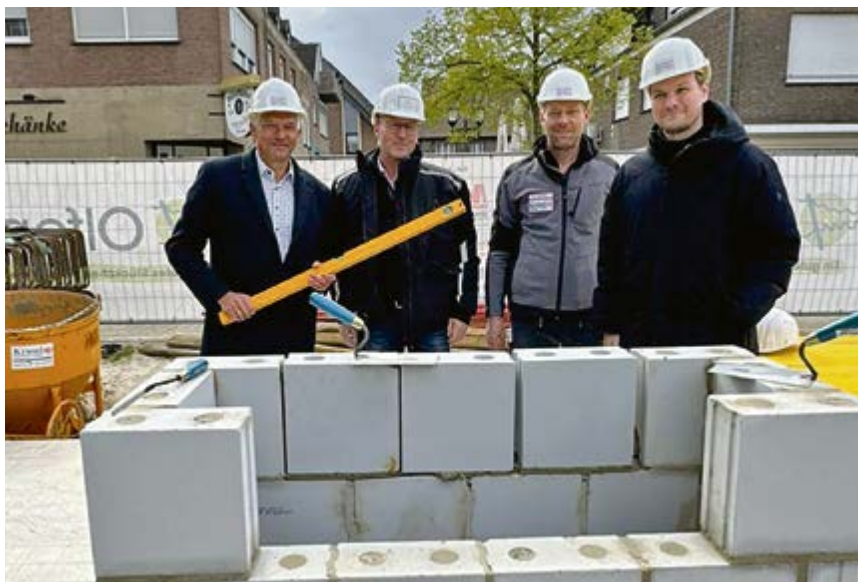
Der Grundstein für das Rathaus ist gelegt. V.l. Wilhelm Sendermann, die Unternehmer Gregor Middelman und Matthias Krusel sowie David Bucker vom zuständigen Architekturbüro.
